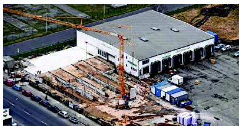
Aus der Vogelperspektive ist die Großbaustelle an der Ecke Am Lundeich/Lofotenstraßen gut zu erkennen. Die vier neuen Laderampen sind schon zu erkennen.
